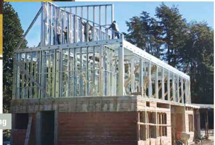
Obra en Steel Framing
